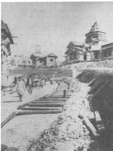
Строительство павильонов выставки.
